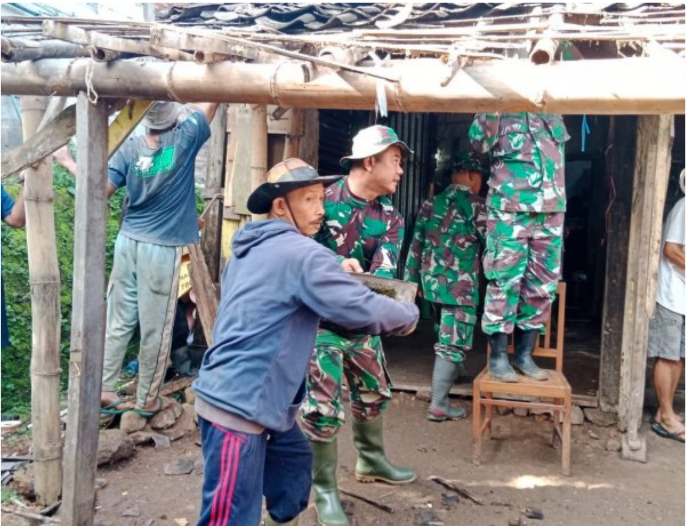
Pembongkar Rumah Sasaran RTLH
