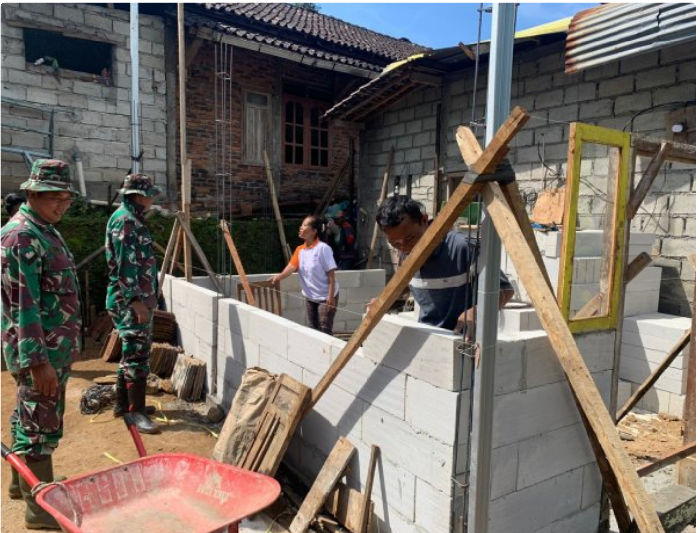
Pemasangan Dinding Menggunakan Herbel
