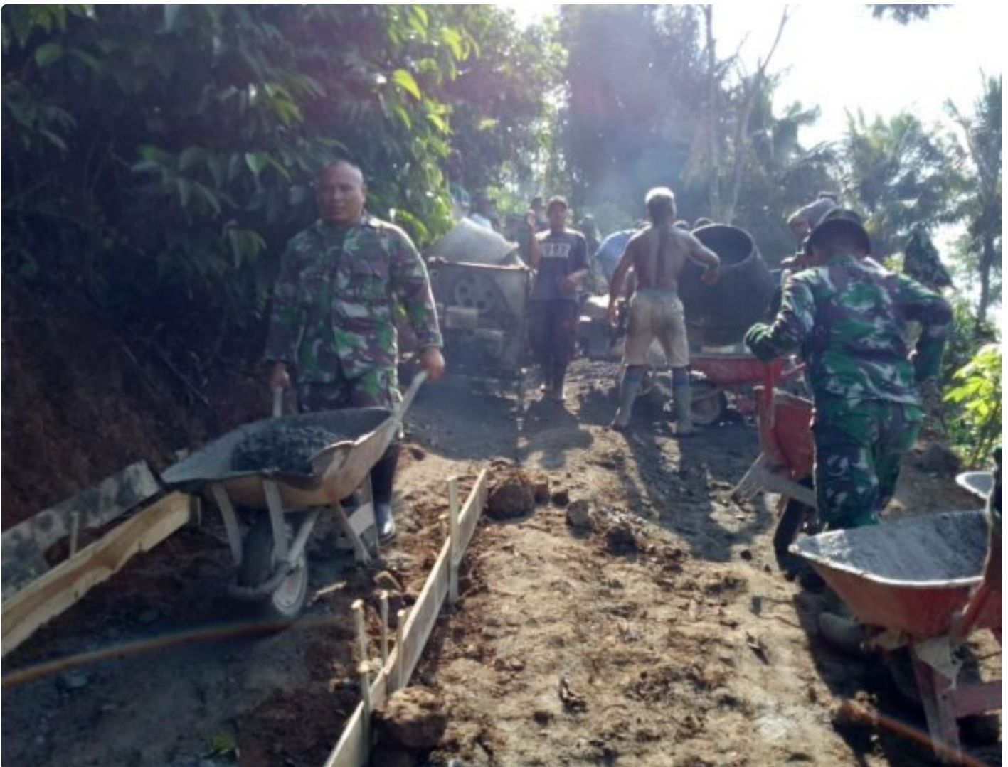
Satgas TMMD Kebut Pengecoran Jalan
